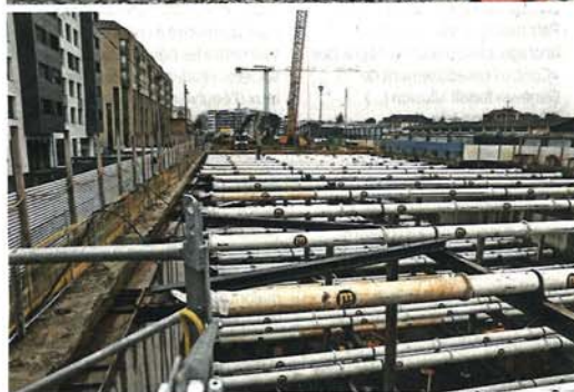
À 17 mètres en dessous du niveau du sol, les ouvriers parachèvent le creusement de la fouille, dans un terrain argileux. Une armature métallique touffue et puissante a dû être déployée pour maintenir l'écartement du terrain. STEVE IJUNCKER-GOMEZ
