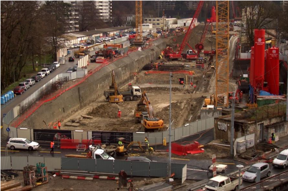
Partie ouverte gare CEVA janvier 2013
