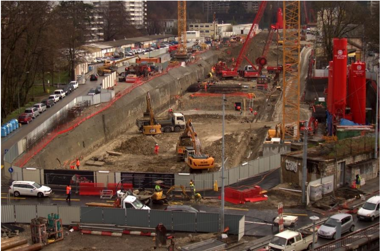
Partie ouverte gare CEVA janvier 2013
