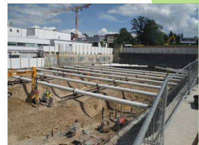
Terrassement dans l'enceinte de fouille de l'Hôpital de la Tour à Meyrin
