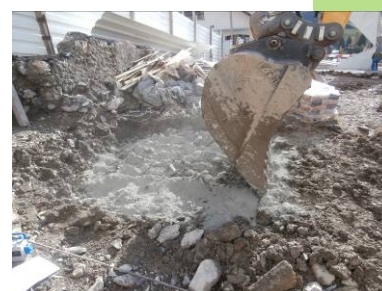
Stabilisation d'un sol au ciment
