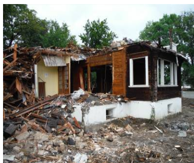
Démolition d'un chalet
